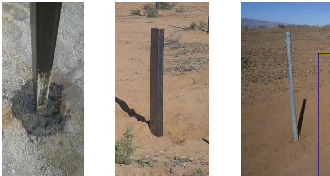
Ilustración 3: Ejemplos de hincado
