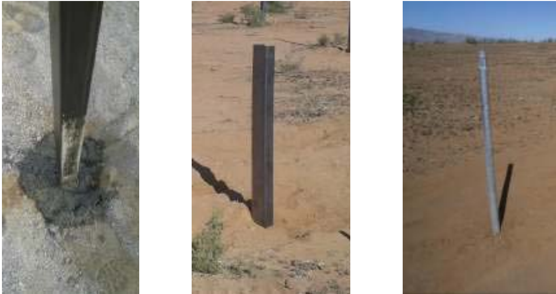
Ilustración 4: Ejemplos de hincado
